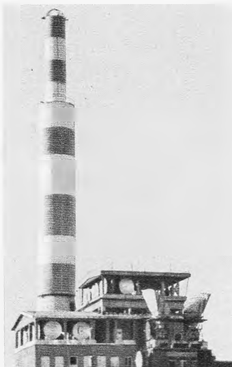
UKW- und Fernseh-Antennenanlage auf dem 2300 m hohen Botev Vrch in Bulgarien. Ein überliegend aus Kunststoff bestehender Eisschutzzyylinder schützt die Antennenelemente vor extremen Witterungseinflüssen (Werkaufnahme: Rohde & Schwarz)
